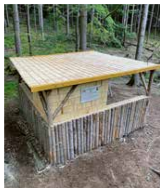
Die renovierte Mäuseburg kann bald eingeweiht werden.
