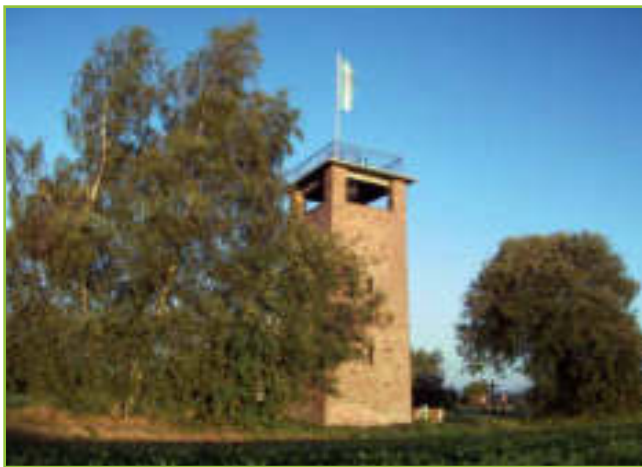
Der 1937 eingeweihte „Kellerturm“
