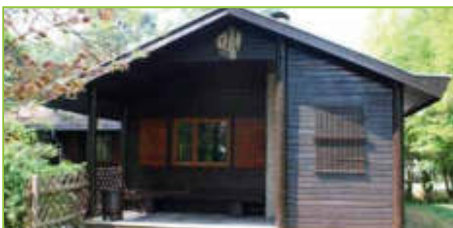
Die 1971 errichtete Spessarthütte
